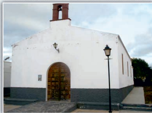
18 – La Asomada . Ntra. Sra. de Fátima. Ermita. Siglo XX (1950...). Cubierta a dos aguas. Espadaña en el centro de la portada principal.
