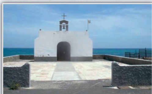
14 – Puerto Lajas . Ntra. Sra. del Pino. Ermita. S.XX (1950...). Cubierta de vertiente sencilla. Espadaña en el centro de la fachada principal.
