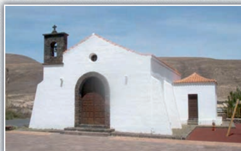
13 – Guisgüey . San Pedro. Ermita. S.XX (1950...). Cubierta a tres aguas, siendo la sacristía cubierta a cuatro aguas. Espadaña a la izquierda de la fachada principal. Óculo en el hastial de la portada principal
