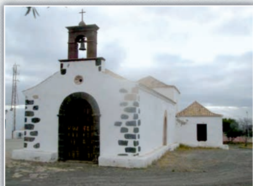
12 – El Time . Ntra. Sra. de la Merced. Ermita. S.XVIII. Cubierta a dos aguas. Espadaña en el centro sobre la fachada principal. Óculo en el hastial del frontis principal.
