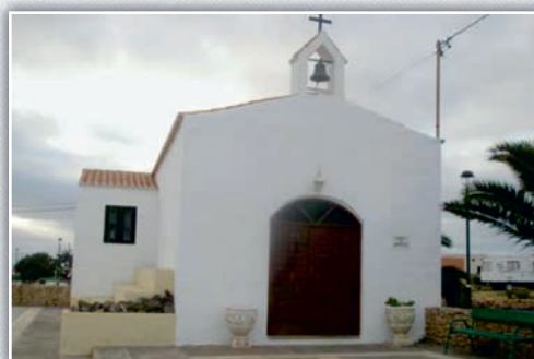
15 – Los Estancos . Santa Rita de Casia. Ermita. S.XX (1950...). Edificio principal cubierto a dos aguas, con sacristía adosada, cubierta igualmente a dos aguas. Espadaña en el centro de la pared principal.
