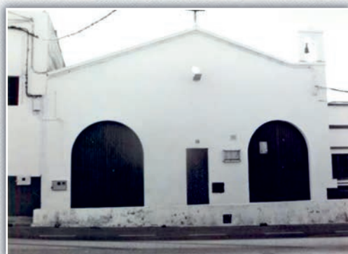
19 – Puerto del Rosario (2), barrio de “El Encharco”. Virgen del Mar. Ermita. S.XX (1950...). Cubierta a dos aguas. Espadaña a la derecha de la portada principal. Óculo hastial en la fachada principal.
