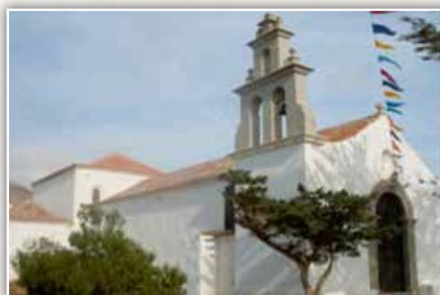
25 – Ampuyenta . San Pedro de Alcántara. Ermita. S.XVII. Cubierta a dos aguas; presbiterio a cuatro aguas. Espadaña a la derecha de la fachada de la izquierda. Óculo en el hastial de la fachada principal.
