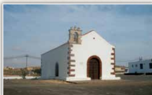
26 – Valle de Santa Inés . Ermita homónima. S.XVI. Cubierta a dos aguas. Espadaña a la izquierda de la fachada principal, con óculo en el hastial de esta fachada.
