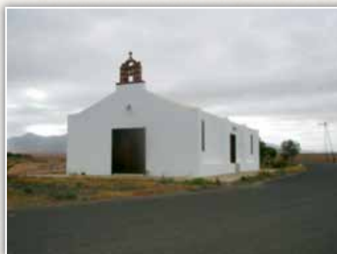
21 – Las Parcelas . San Andrés. Ermita. S.XX (1950...). Cubierta a dos aguas. Espadaña en el centro de la fachada principal.
