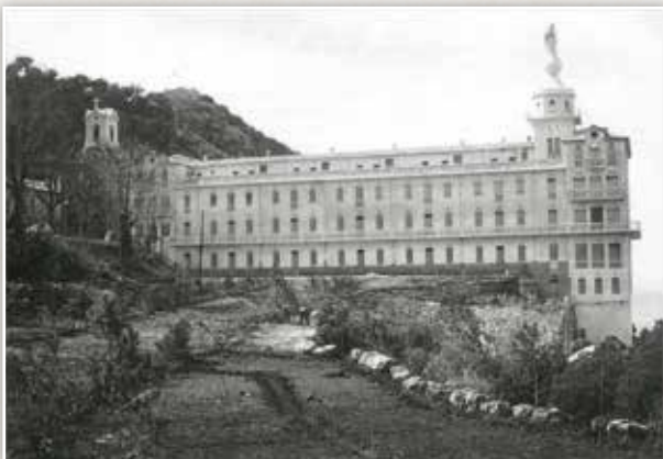
Panoràmica general de l'antic edifici de la Font Roja, on veiem la Puríssima de Peresejo i Torregrosa.
