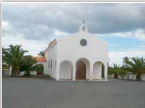
28 – El Matorral . San Juan. Ermita. S.XX (1950...) Cubierta a dos aguas; sacristía adosada cubierta a dos aguas. Espadaña en el centro de la fachada principal.
