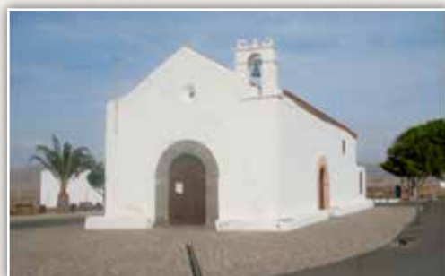
24 – Llanos de la Concepción . Ermita homónima. S.XVIII. Cubierta a tres aguas. Sacristía a cuatro aguas. Óculo en el hastial del frontis. Espadaña a la derecha de la pared principal.
