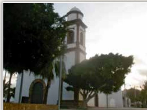
30 – La Antigua . Iglesia parroquial homónima. S.XVII Cubierta a dos aguas. Torre-campanario adosada a la derecha de la pared principal.
