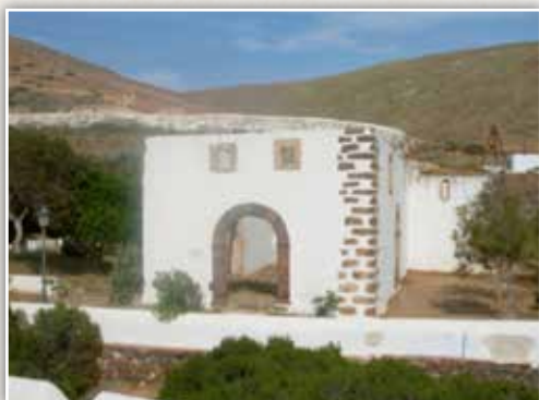
29 – Betancuria (2) . San Buenaventura. Iglesia conventual. S.XV. Templo de mampostería, con cantería en los soportes y vanos. Planta de doble cruz latina. Solo se conservan los muros.
